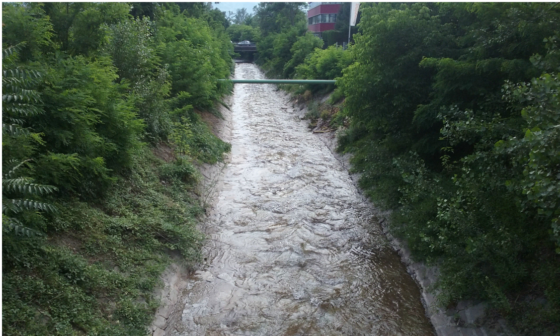
Nicht revitalisierter und verbauter Haflingerbach in Sinich
